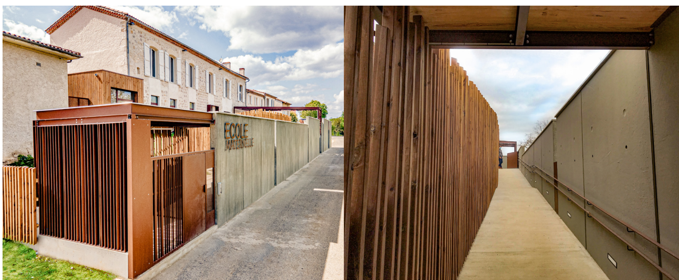
La rampe de l'école permet de répondre aux exigences d'accessibilité tout en constituant une vraie pièce d'architecture, avec un usage de sas. © Agence Airoidi architectes
