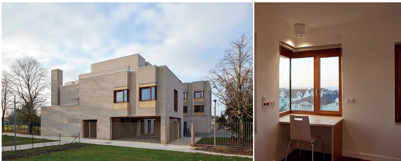
Architecte : Harari. Photographe : Antoine Mercuzot
