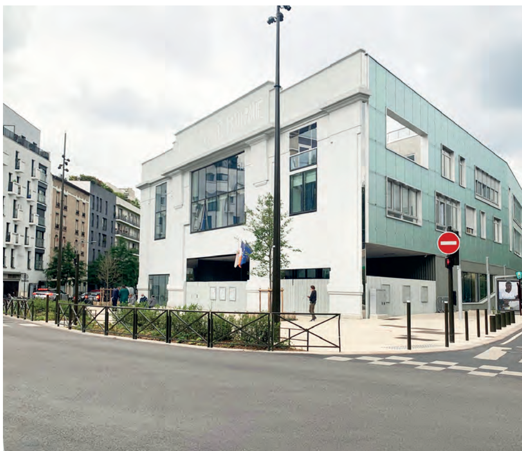
Lycée du Trapèze, Boulogne-Billancourt (92).
