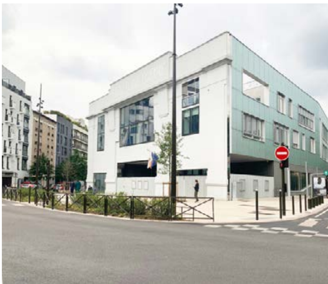
Lycée du Trapèze, Boulogne-Billancourt (92).
